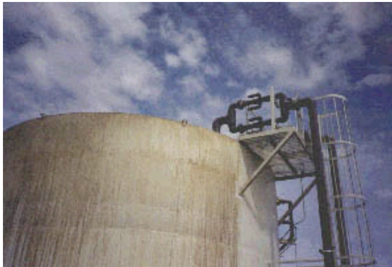
2 vues de la même installation
